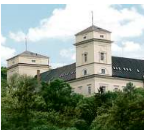
Zámek Račice, přestavba
