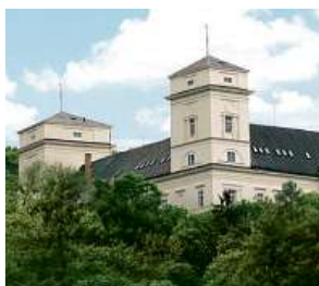
Zámek Račice, přestavba
