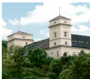
Zámek Račice, přestavba
