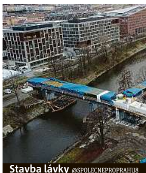
Stavba lávky @SPOLECNĚPRAHUS
