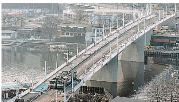
Stavba Dvoreckého mostu jde do finále. Takhle probíhala zátěžová zkouška před zhruba dvěma týdny. MAFRA
