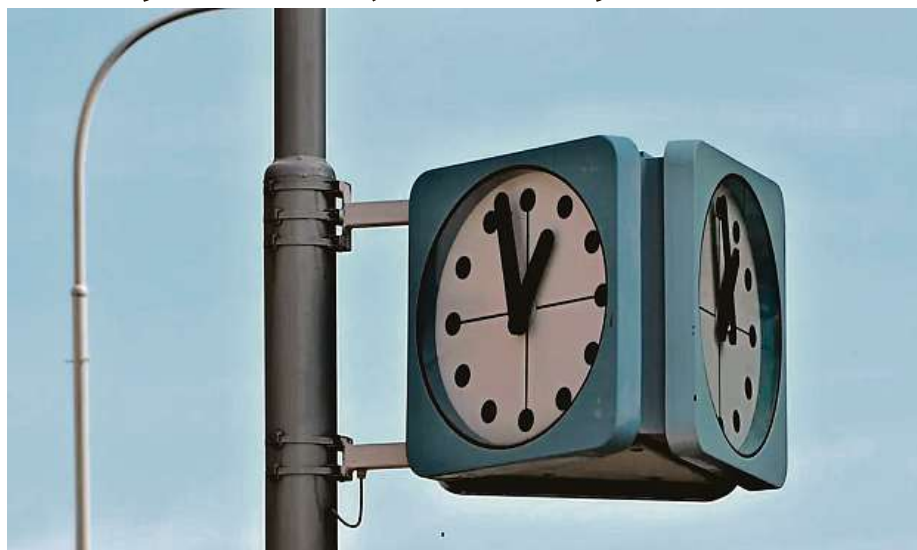
Dálkově přes speciální software řídí a seřizují pražské pulkrabky pracovníci městské firmy Technologie hlavního města Prahy (THMP).
