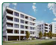
Bytové domy Břeclav, ul. Charvátská
