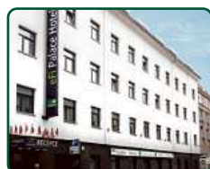
eFi Palace Hotel, Brno, dokončené 2 etapy
