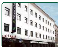
eFi Palace Hotel, Brno, dokončené 2 etapy
