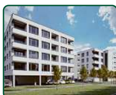
Bytové domy Břeclav, ul. Charvátská
