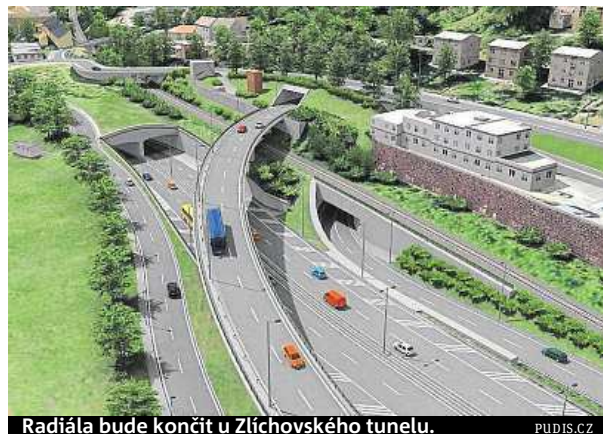
Radiála bude končit u Zlíchovského tunelu.
