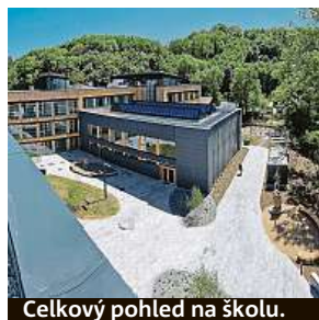
Celkový pohled na školu.
