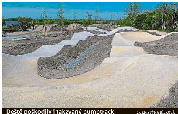
Deště poškodily i takzvaný pumptrack.
