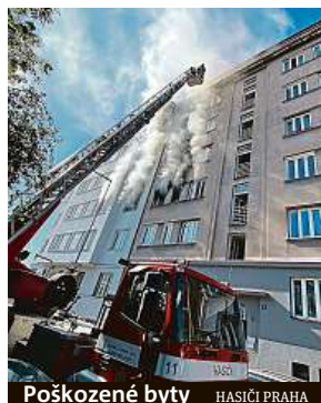
Poškozené byty HASIČI PRAHA
