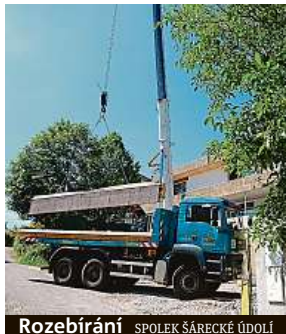
Rozebírání SPOLEK ŠÁRECKÉ ÚDOLÍ
