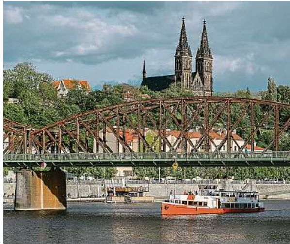
Na železničním mostě je momentálně omezen provoz.
