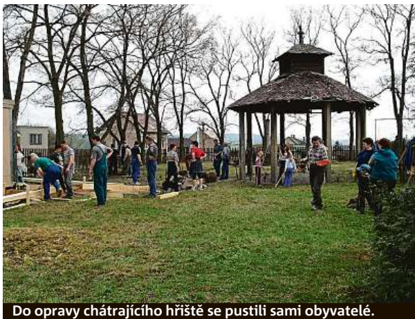
Do opravy chátrajícího hřiště se pustili sami obyvatelé.
