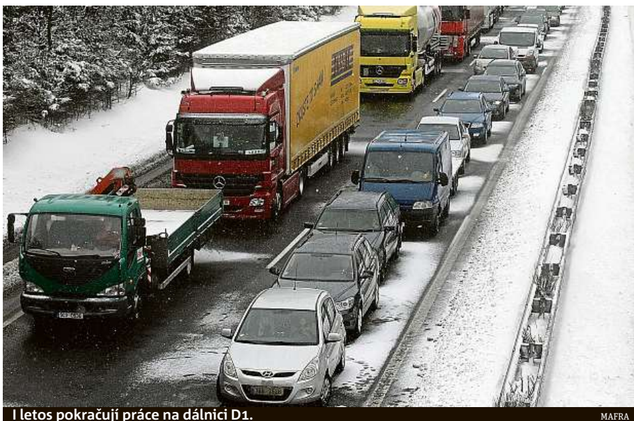
I letos pokračují práce na dálnici D1.
