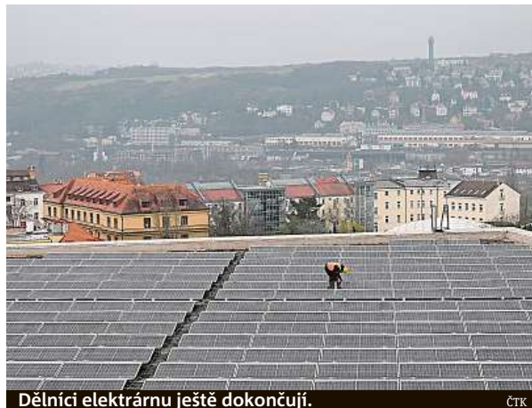
Dělníci elektrárnu ještě dokončují. ČTK
