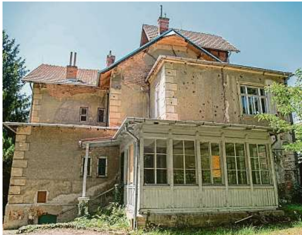
Arnoldovu vilu zachrání rozsáhlá rekonstrukce.
