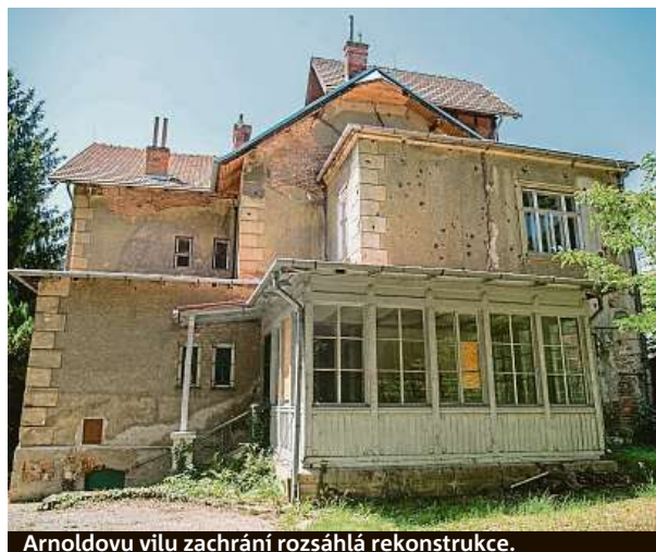
Arnoldovu vilu zachrání rozsáhlá rekonstrukce.
