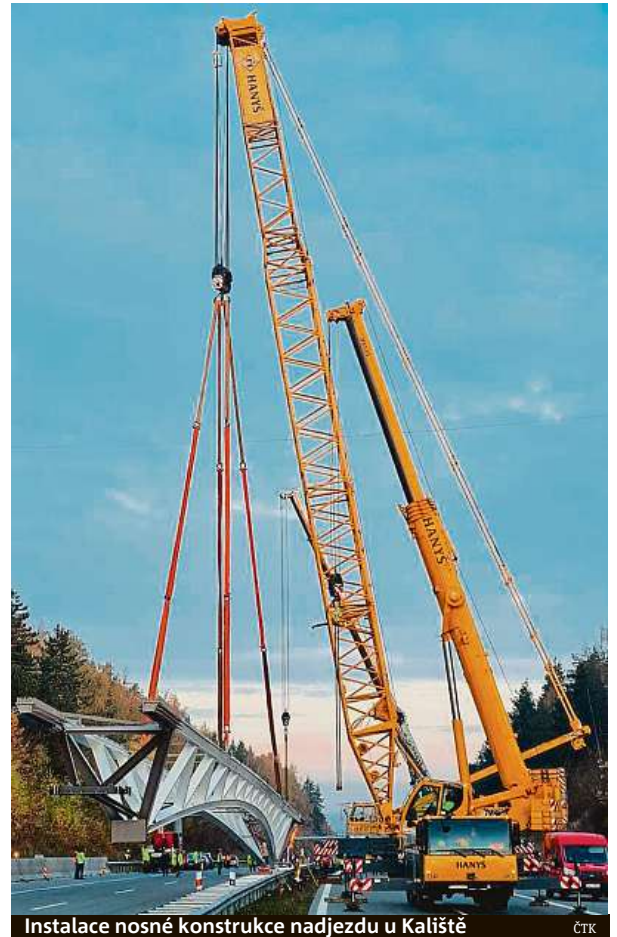
Instalace nosné konstrukce nadjezdu u Kaliště
