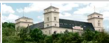
Zámek Račice, přestavba
