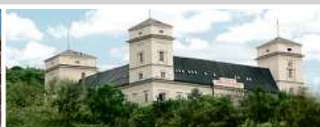
Zámek Račice, přestavba
