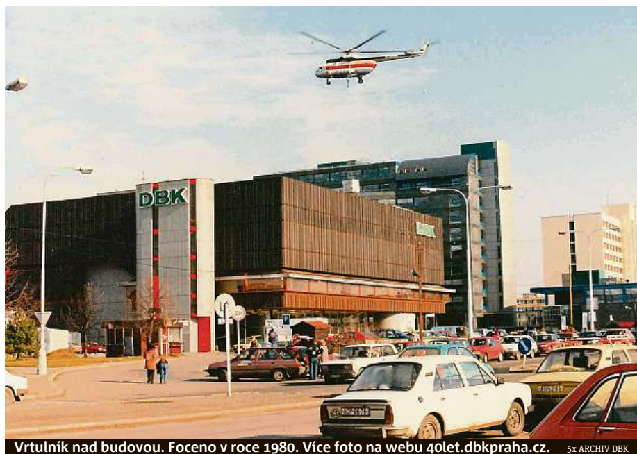
Vrtulník nad budovou. Foceno v roce 1980. Více foto na webu 40let.dbkpraha.cz.
