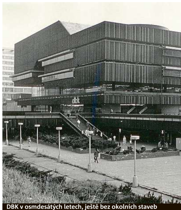
DBK v osmdesátých letech, ještě bez okolních staveb
