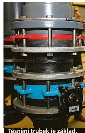
Těsnění trubek je základem oprav.
