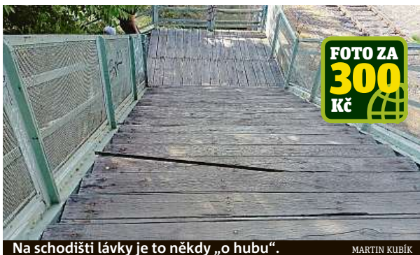
Na schodišti lávky je to někdy „o hubu“.
