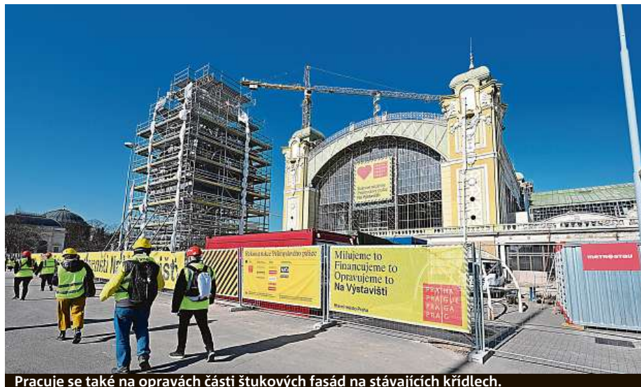
Pracuje se také na opravách části štukových fasád na stávajících křídlech.
