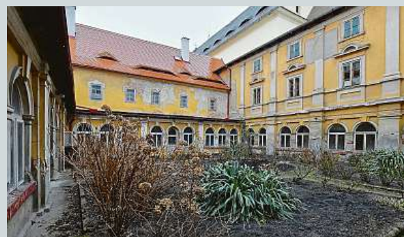
Oprava bývalého kapucinského kláštera
