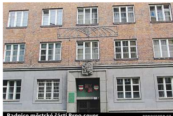
Radnice městské části Brno-sever
