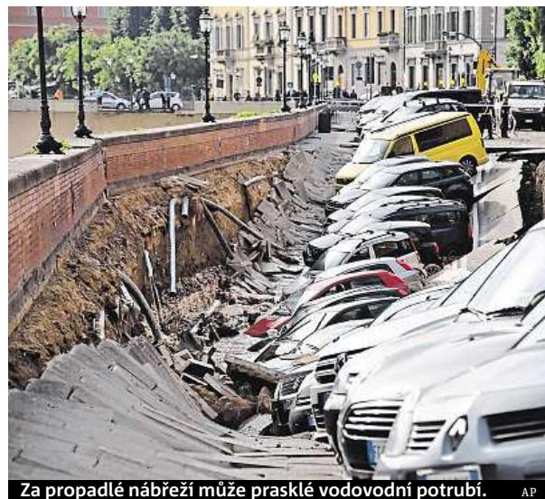
Za propadlé nábřeží může prasklé vodovodní potrubí.
