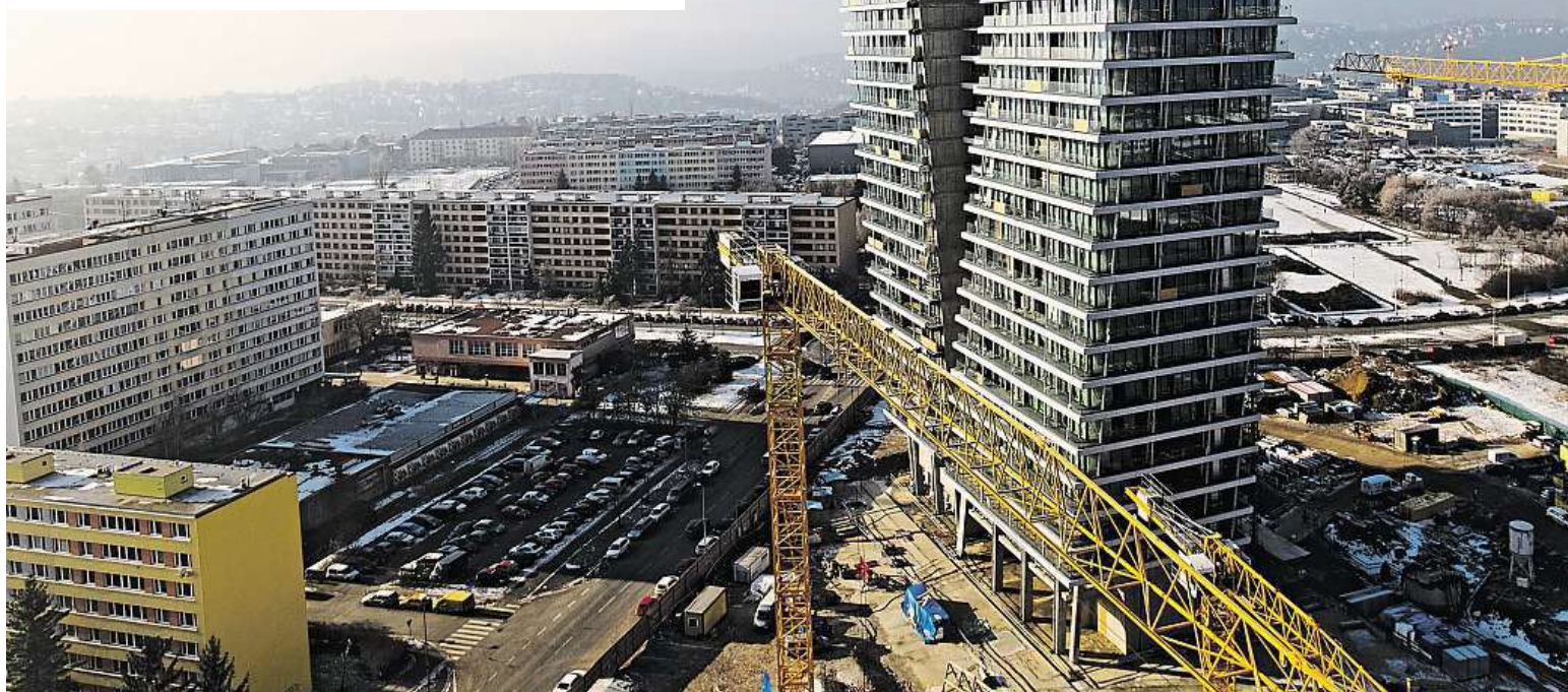
Nejvyšší bod, tedy 104 metrů nad zemí, už stavba dosáhla na začátku letošního roku.
